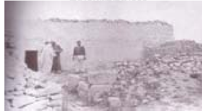
شكل 185 الجهة الجنوبية الشرقية لمسجد الكنيسة بتمزدة
