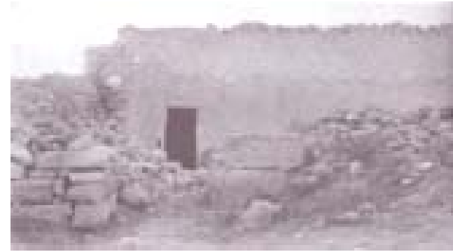
شكل 184 الجهة الجنوبية الشرقية لمسجد الكنيسة بتمزدة
