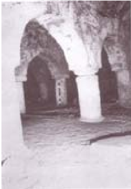
شكل 177 قاعة الصلاة بمسجد الكنيسة بتمزدة
