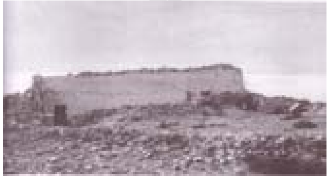
شكل 174 الجدار الجنوبي الشرقي لمسجد الكنيسة بتمزدة
