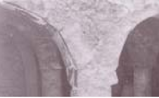
شكل 176 قاعة الصلاة بمسجد الكنيسة بتمزدة
