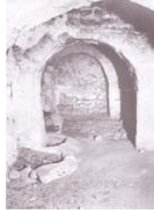
شكل 182 قاعة الصلاة بمسجد الكنيسة بتمزدة
