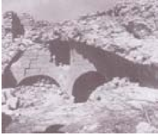
شكل 171 بقايا آثار منزل متصدع بقرية ويغو القديمة
