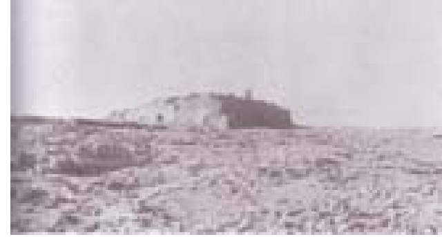
شكل 112 مسجد شروس ومدخله الجنوبي الغربي
