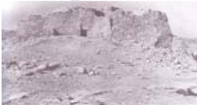
شكل 114 الجدار الجنوبي الغربي لمسجد شروس
