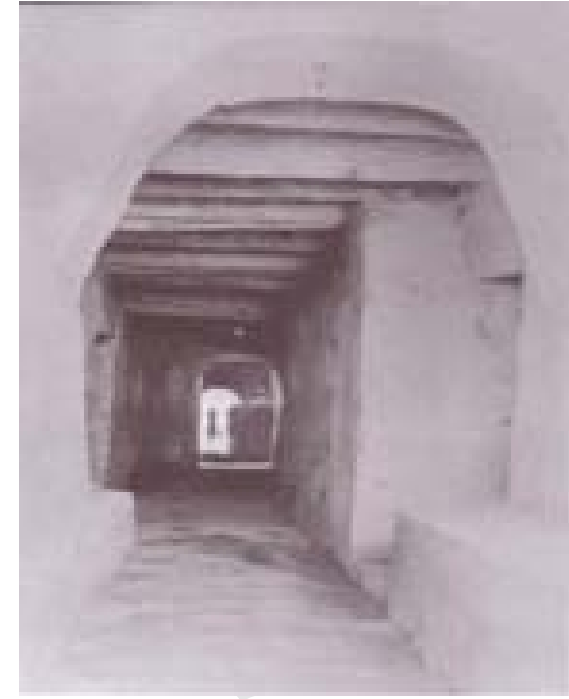
شكل 60 شارع من شوارع مدينة غدامس القديمة
